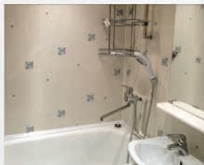
Отделка ванной 2,2м 2 ПВХ панелями
